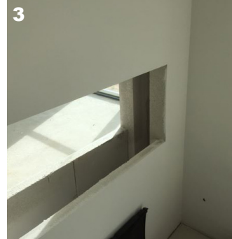
3 La paroi du foyer n'est pas protégée contre les faux courants d'air sur les côtés.
